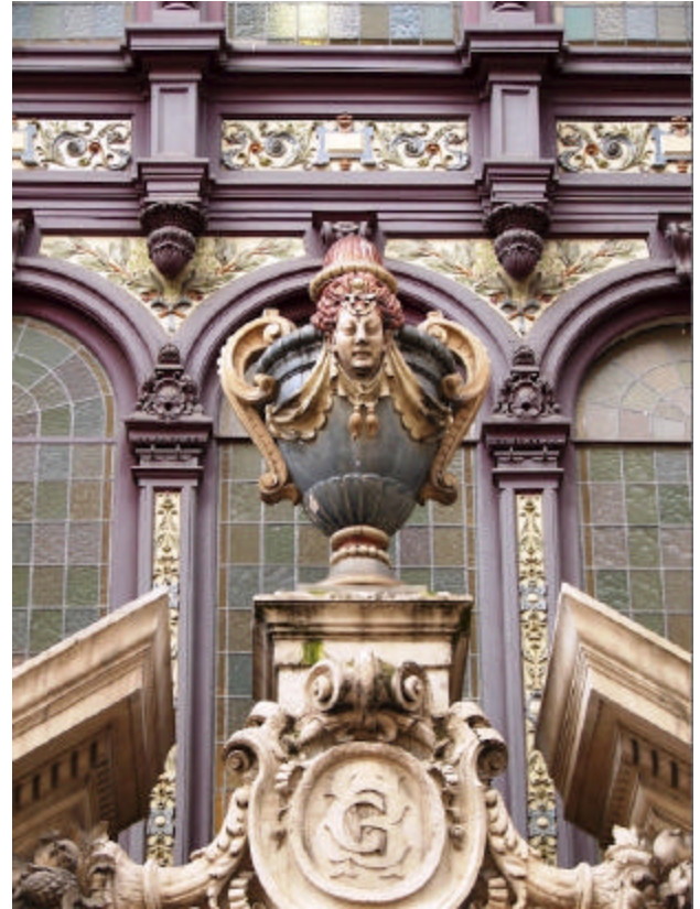
Detail of the façade 18 rue de Paradis
